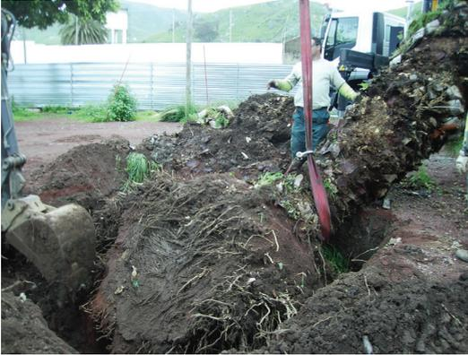
Figure 37. Opération d'extraction pour transplantation d'un exemplaire de *Phoenix canariensis* sur un sol argileux, compact
